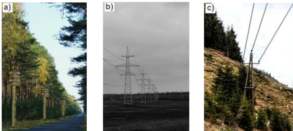
Fot.1. Ilustracja warunków środowiskowych linii: a) osłoniętej drzewami, b) odosobnionej na równinie, c) eksponowanej na wzgórzu [8]
