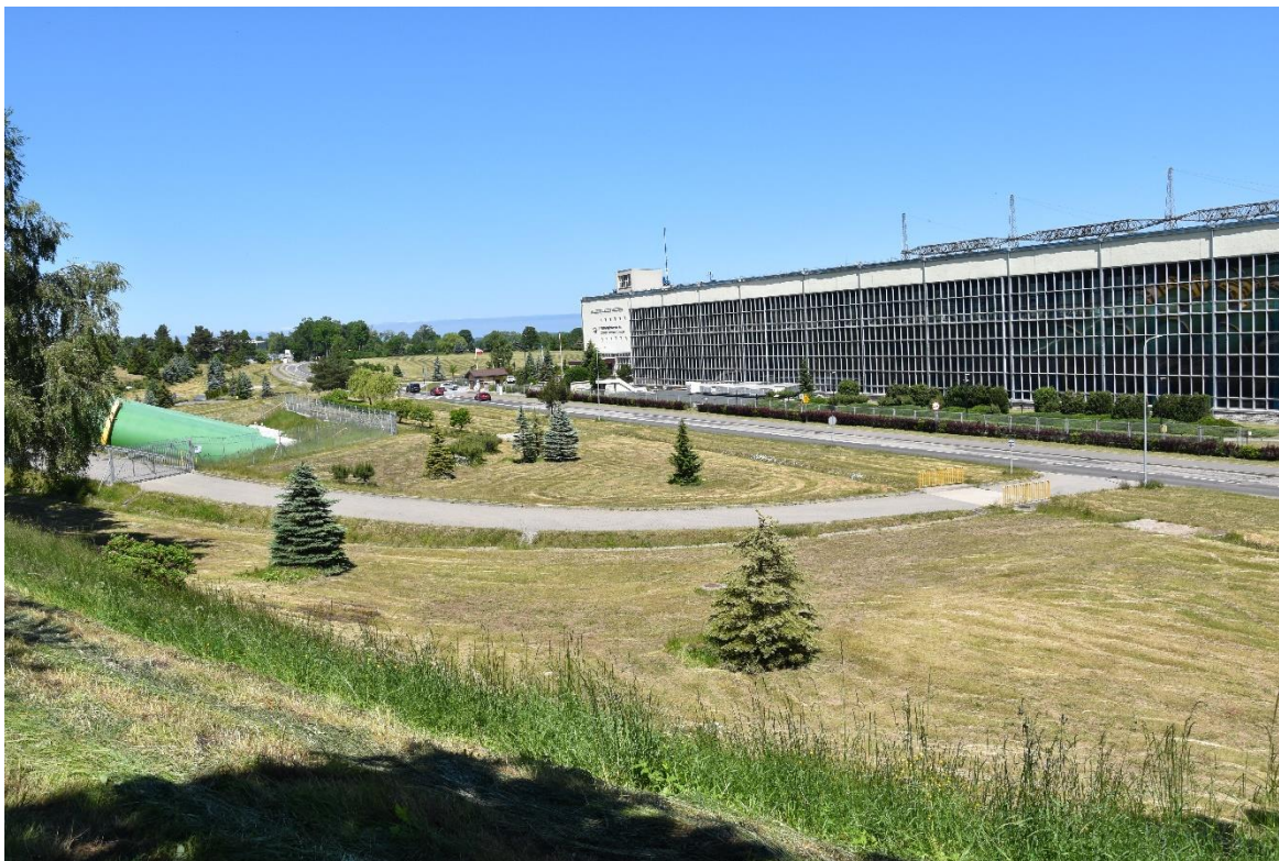
Budynek elektrowni od frontu, z lewej strony widoczna zielona rura górnej wody
