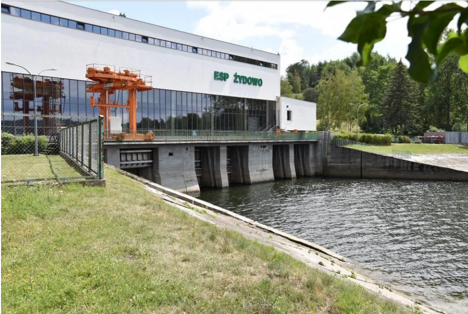
Fot. 5. Budynek elektrowni z wypływem dolnej wody.
